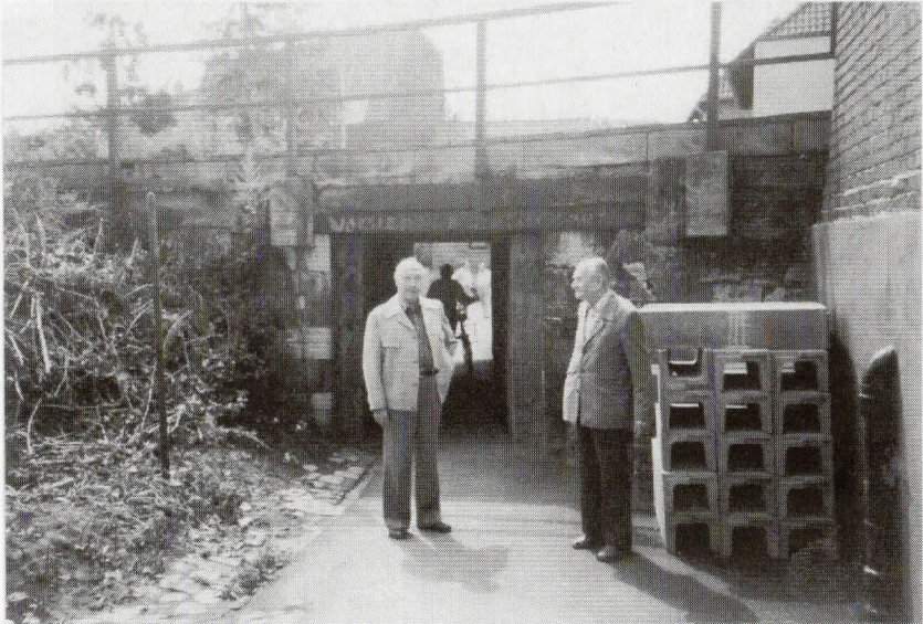
Das Tunnelchen in Höhe der Jahnstraße
